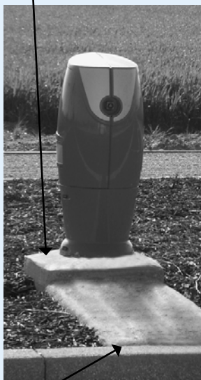
Soacle d'ancrage permettant une mise à niveau future du sol fini.
